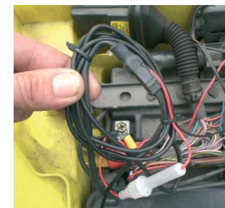
Kabelsalat: Kein Problem beim Scotttoiler, nur zwei Kabel müssen montiert werden.
